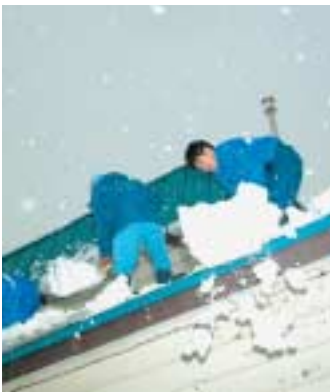
豪雪地青森市にはなくてはならない屋根の雪下ろし
